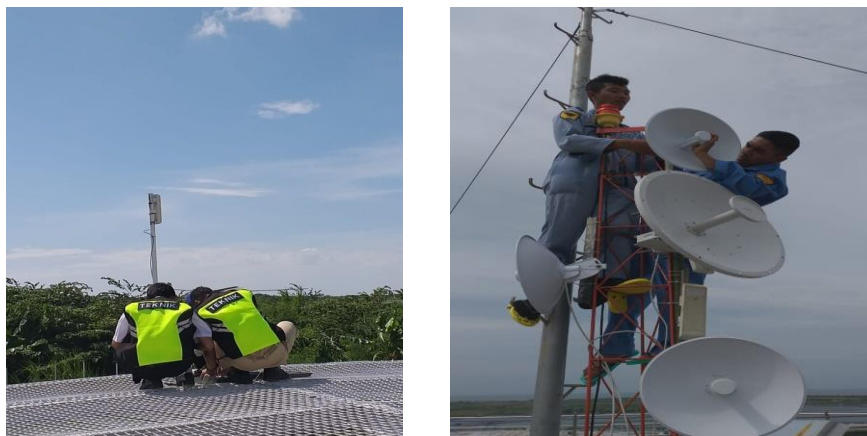
Gambar 16. Pemasangan Radio Link
