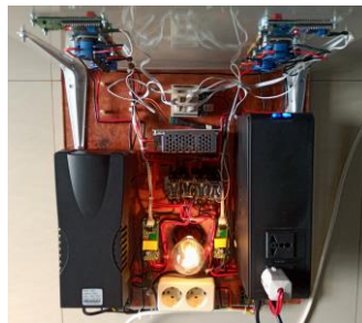
Gambar 3 Pengujian besaran listrik pada masing – masing luaran UPS
