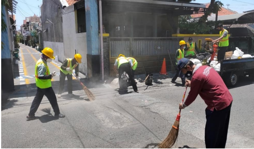
Gambar 3. Pembrsihan titik lokasi jalan yang akan diperbaiki
