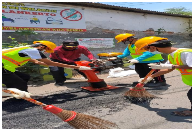
Gambar 5. Pemerataan aspal dengan alat pemadat aspal
