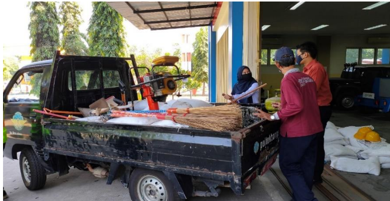
Gambar 1. Persiapan Bahan dan alat untuk perbaikan jalan
