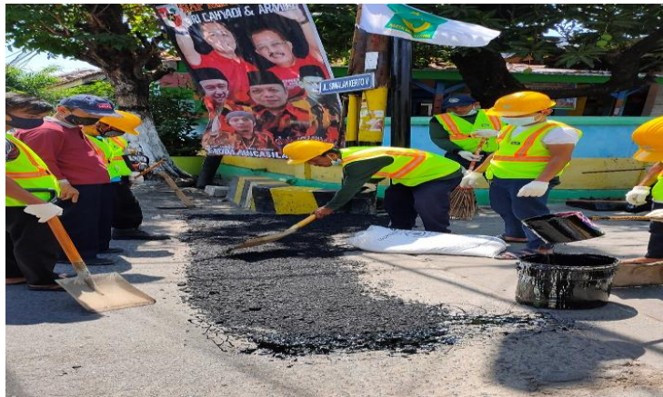
Gambar 4. Menebarkan Aspal pada jalan hingga diperoleh permukaan rata
