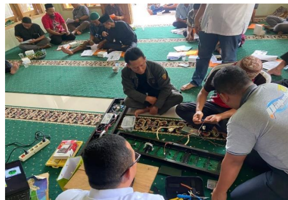
Gambar 2. Installasi Jam waktu sholat Khalifah Controller
