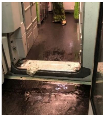
Figure 1.2. AC di dalam garbarata bocor
