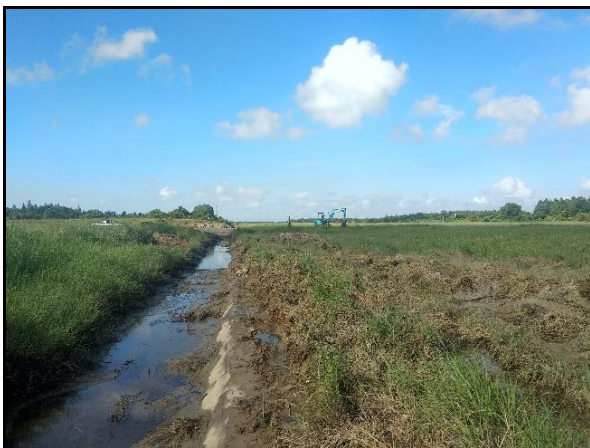
Gambar 8. Kondisi drainase runway strip setelah dilakukan pekerjaan pembersihan endapan
