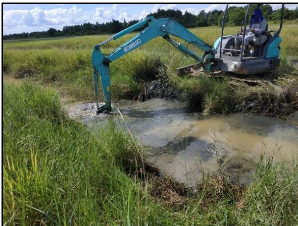
Gambar 7. Pekerjaan pembersihan endapan drianase runway strip
