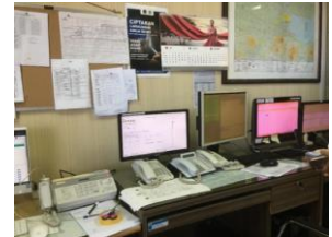
Gambar 2 Peralatan Fax, AMSC, TERN ATC System, dan komputer (Chronos) di ruang ATS RO
