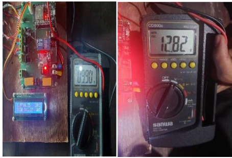
Gambar 2 Pengujian tegangan DC pada battery
