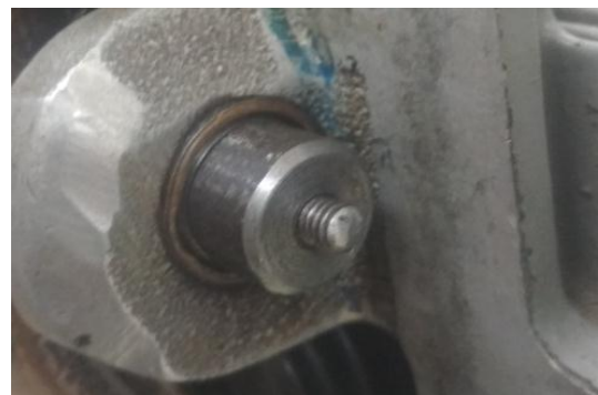
Gambar 9 Pemasangan nut dan washer
