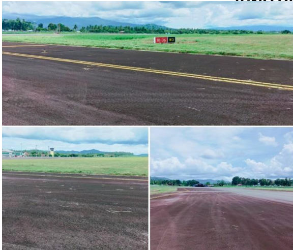
Gambar 4.1. kondisi Taxiway pararell setelah maintance pesawat (Sumber : file document Tower )
