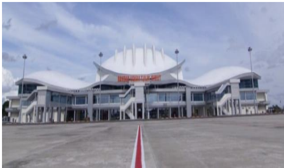
Gambar 1 Floodlight Pada Bandar Udara Tjilik Riwut Sumber: Dokumen Bandara
