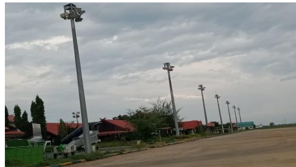
Gambar 2 Floodlight Pada Bandar Udara Tjilik Riwut Sumber: Dokumen Bandara
