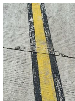
Gambar 1 Kerusakan Gompal Sambungan Pada Taxiway
