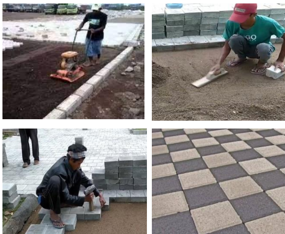
Gambar 11 Contoh Pemasangan Paving Block
