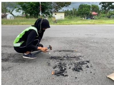
Gambar 12 Pembongkaran Aspal Eksisting
