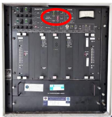
Gambar 2 Alarm pada Integral Peralatan Localizer
