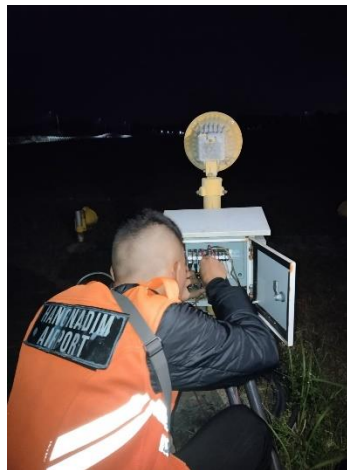
Gambar 6. Melakukan Pemasangan Modul
