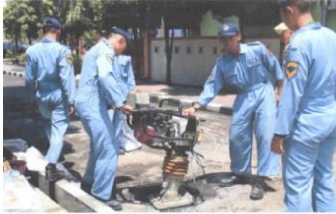
Gambar 2. Taruna membantu memampatkan tanah sebelum dilakukan pemasangan paving block
